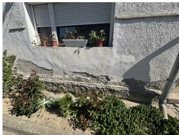
Felázás nyomai a homlokzaton
